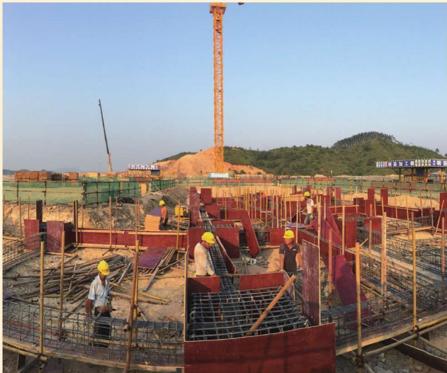
■ 在建的梧州西江机场航站工程（梧州市委办 供图）
