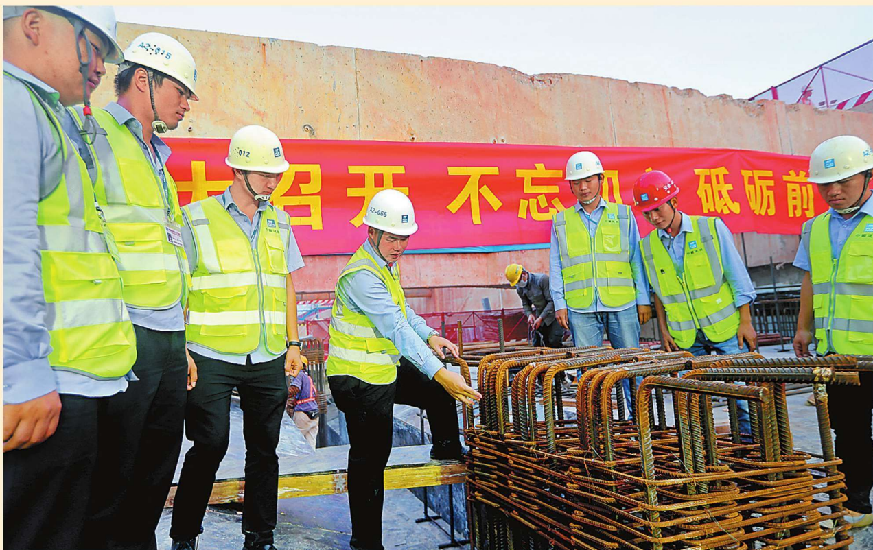
■ 10月22日，在南宁市地铁4号线金阳路站施工现场，中建第八工程局广西公司的一线党员及技术骨干在学习党的十九大报告精神后，以更大的热情投入项目建设中（李 军 摄）
