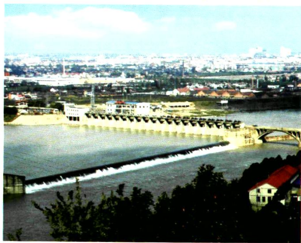
澧水明珠—艳洲电站
