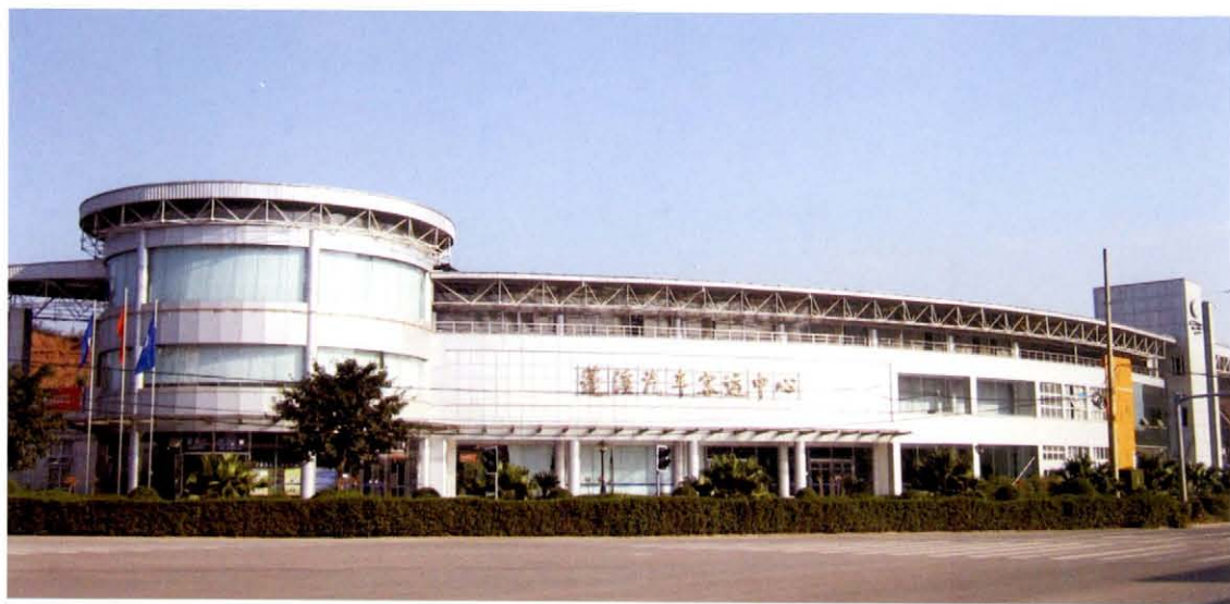
蓬溪县客运中心
