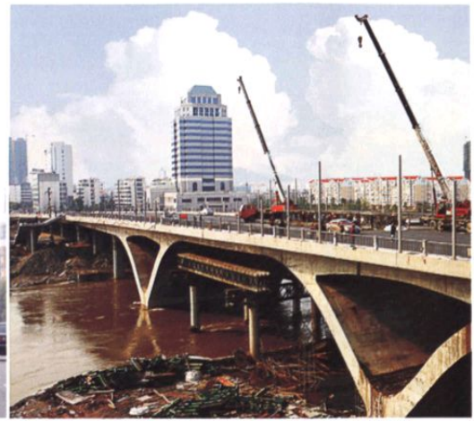
宜春袁山大桥（建设中）
