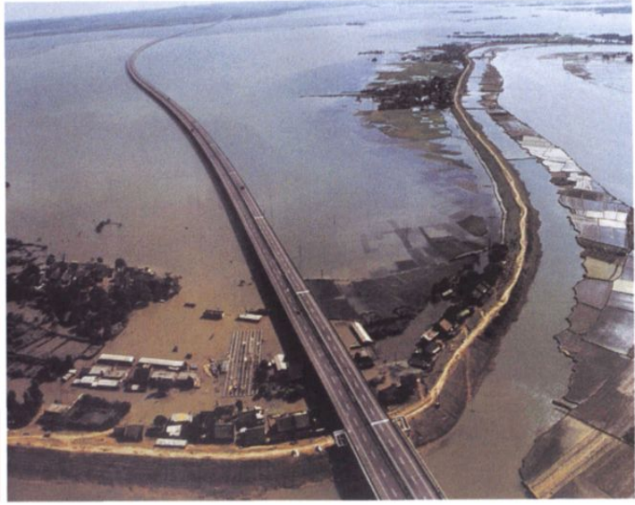
赣粤高速公路（药湖大桥）
