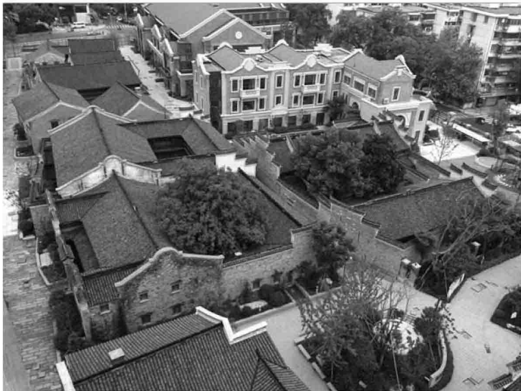
图 1-2 宁波市莲桥街商业文化街区
