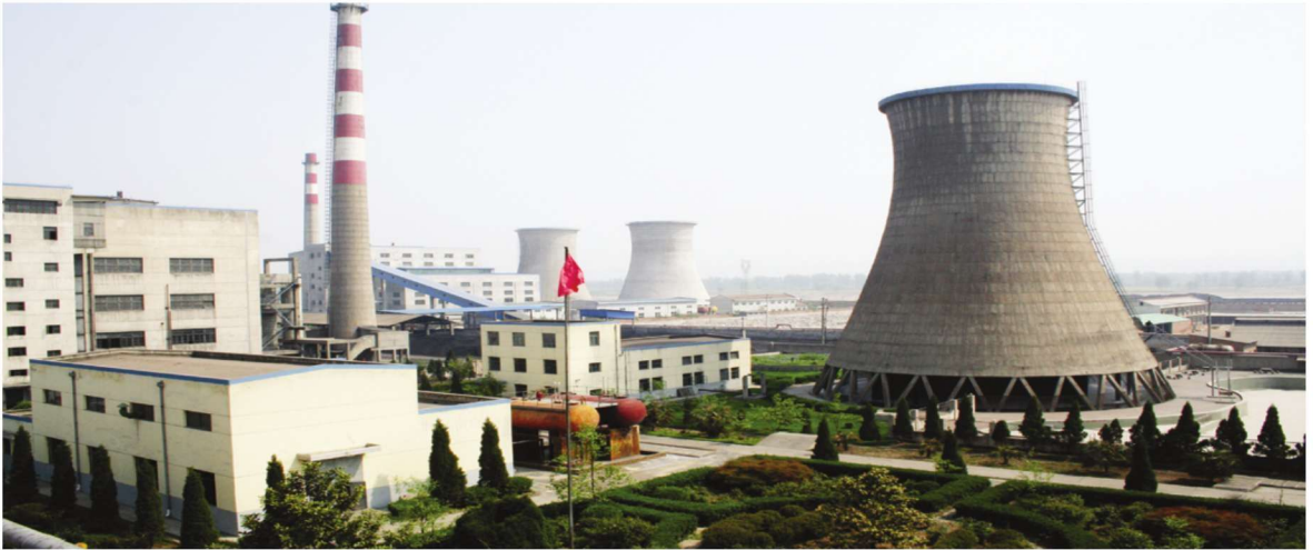
岐星电力有限公司
