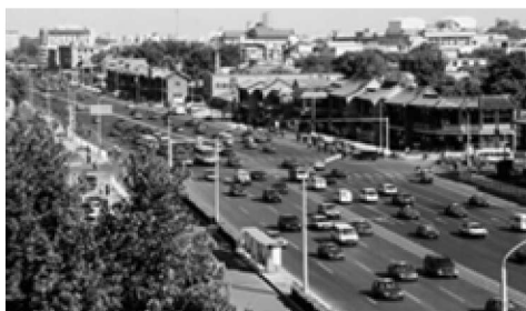
图 1-2-1 北京市南中轴快速公交工程
