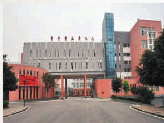
巴南中学综合楼
