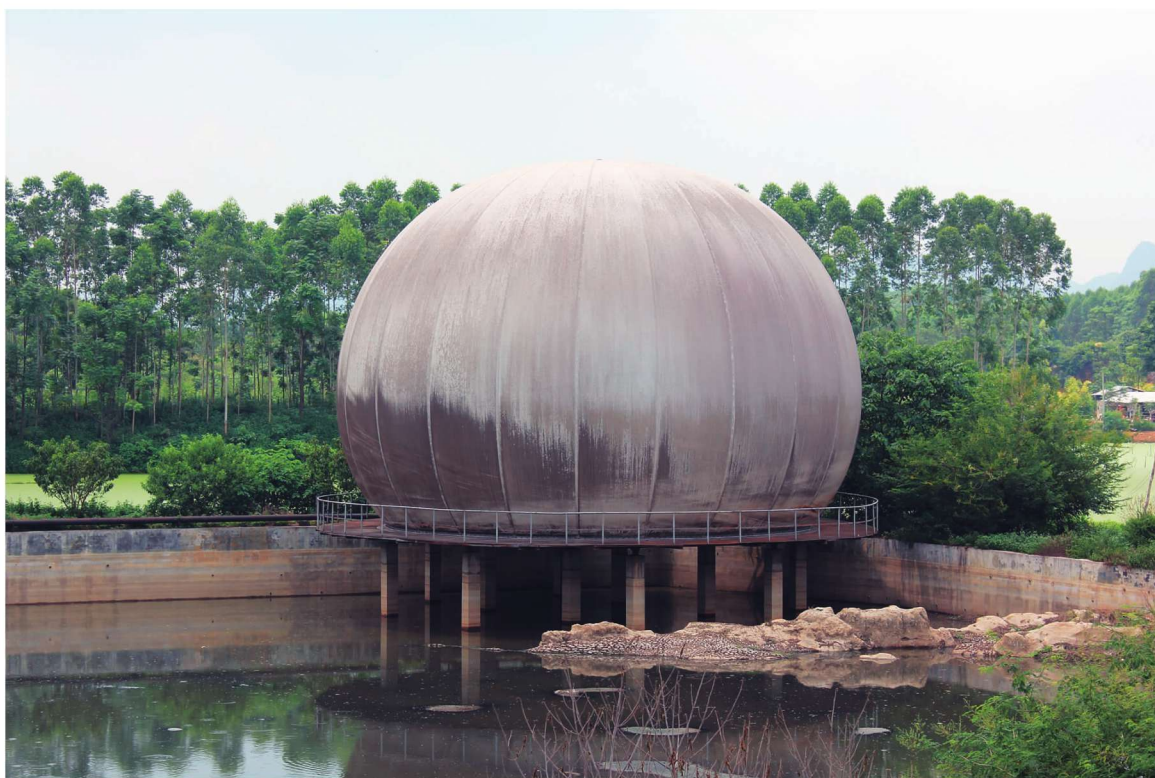
容积 2 500 m 3 双膜沼气储气柜（广西武鸣）
