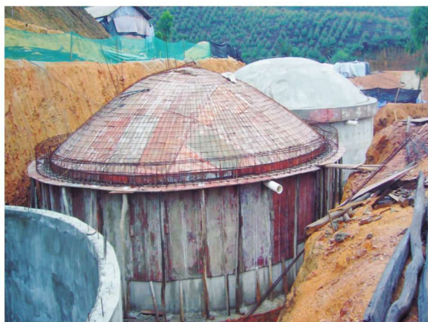
建造地埋式钢筋混凝土沼气池
