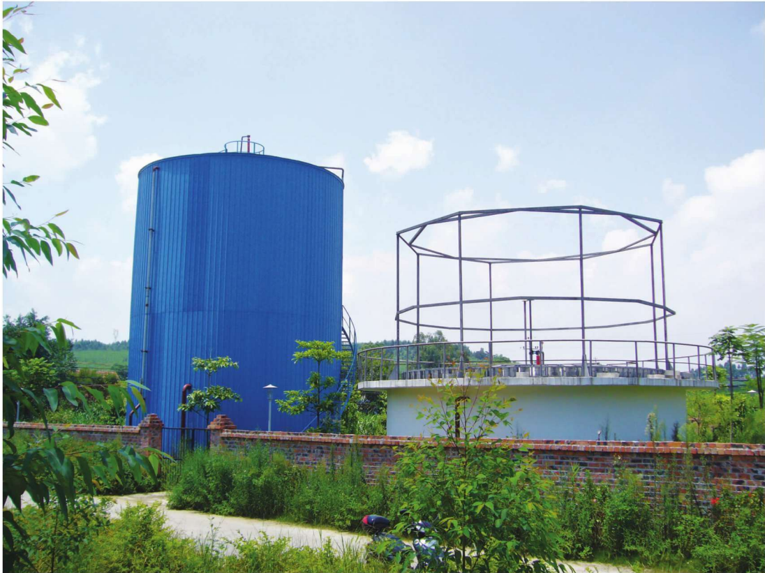
升流式固体反应器（USR）（广西南宁）
