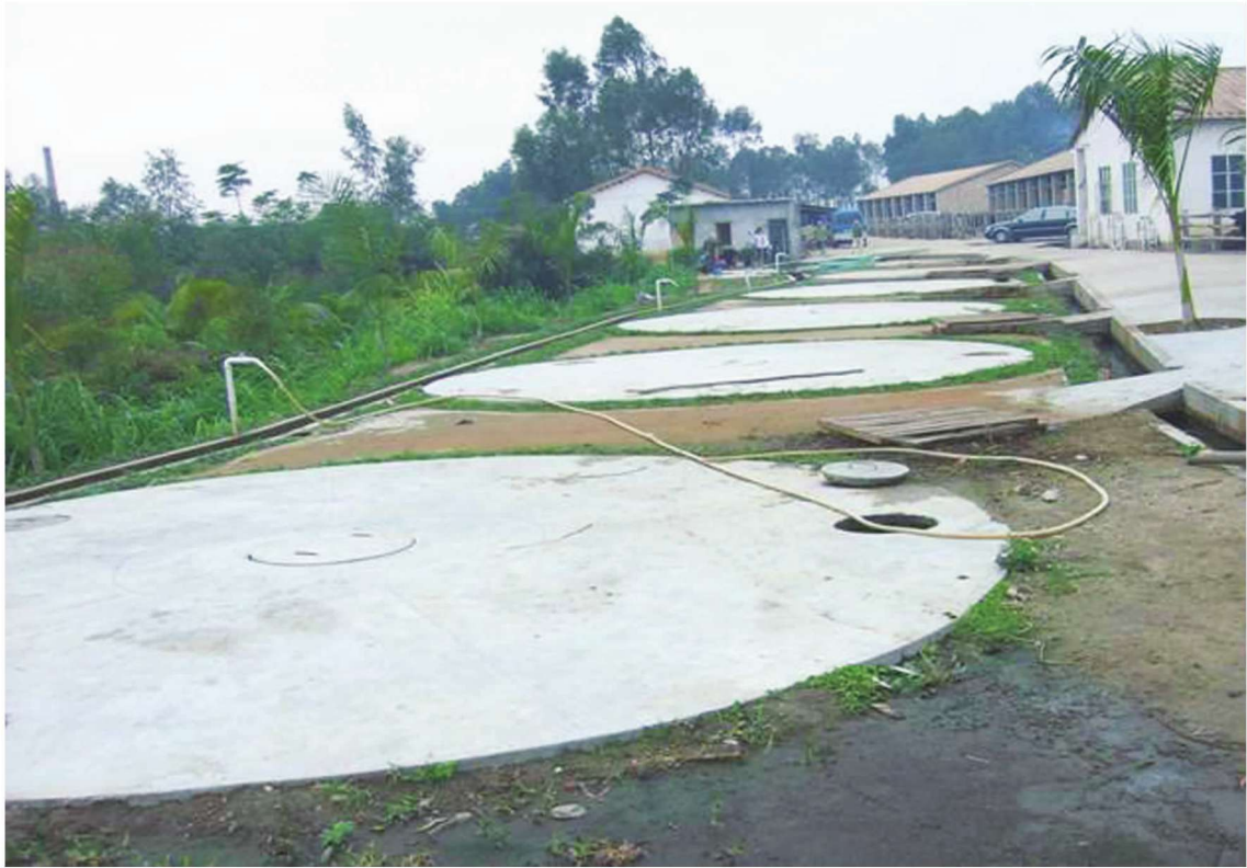
地埋式钢筋混凝土大型沼气池群（广西合浦）
