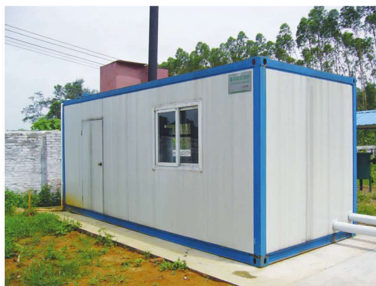
集装箱式沼气锅炉
