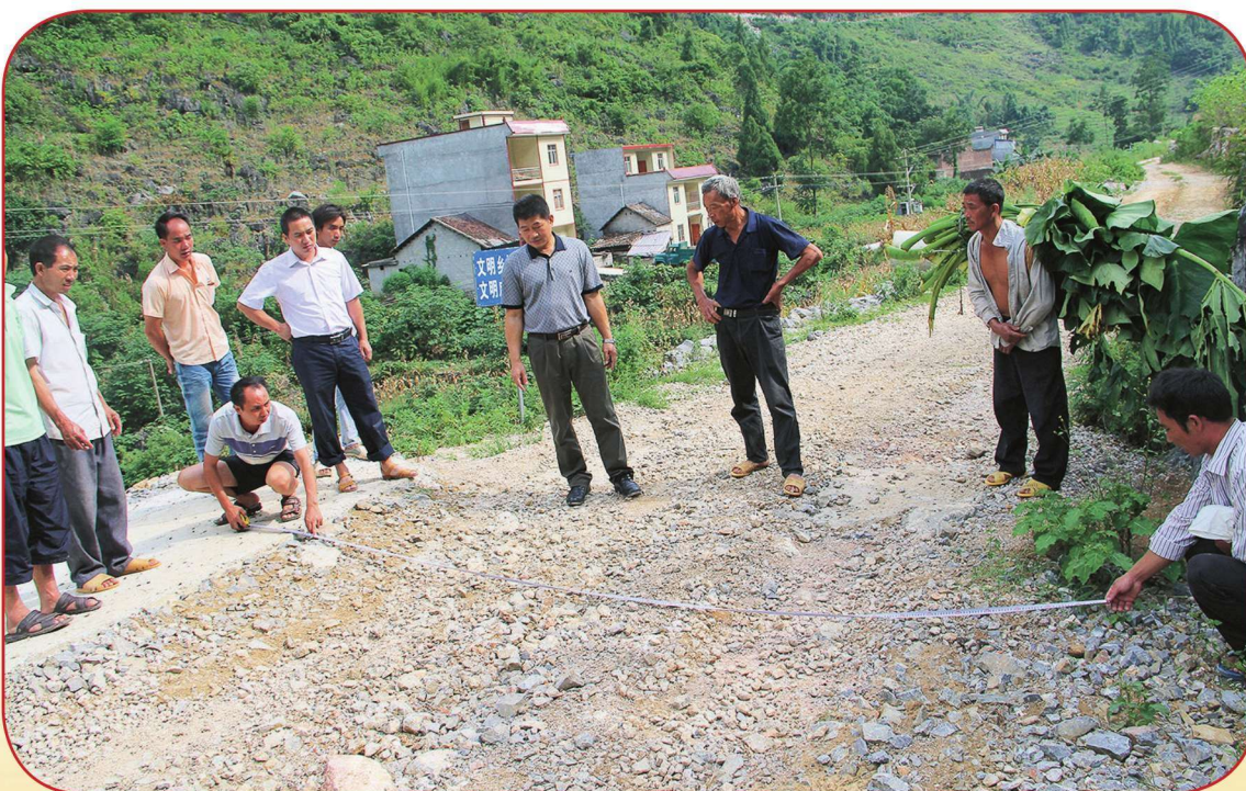
2014年8月27日，凌云县政协主席岑景蔚（右四）到加尤镇伟八村陇酸屯检查指导屯级道路硬化项目建设
