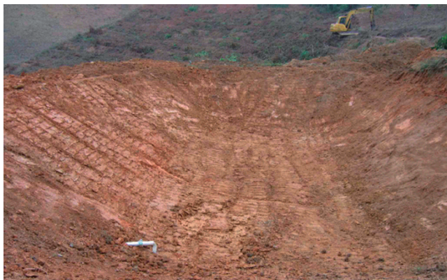
图6 挖坡上蓄水池
