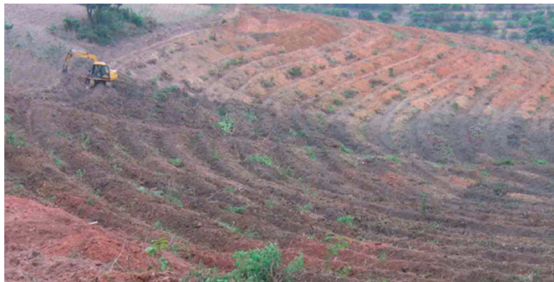
图5 勾机修水平梯田
