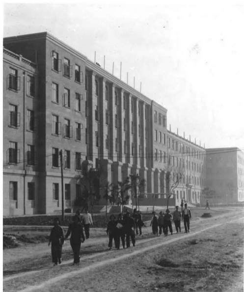
主楼投入使用
