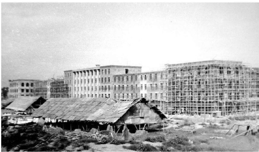
正在修建中的主楼
