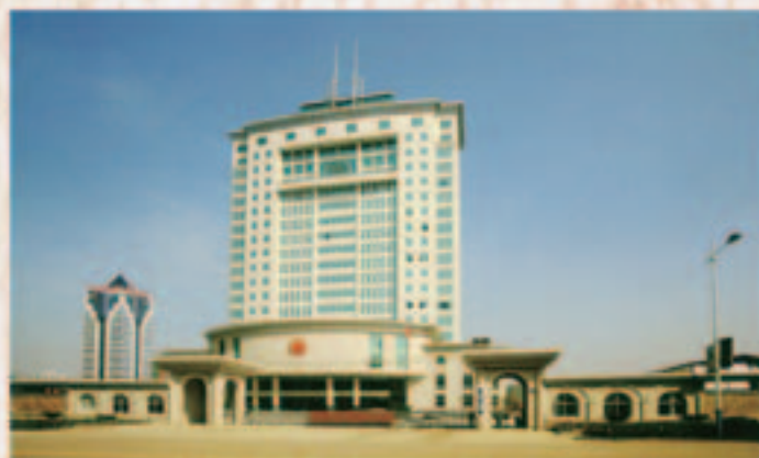
柳州市审计局位于市高新一路1号 图为市审计检察大楼
