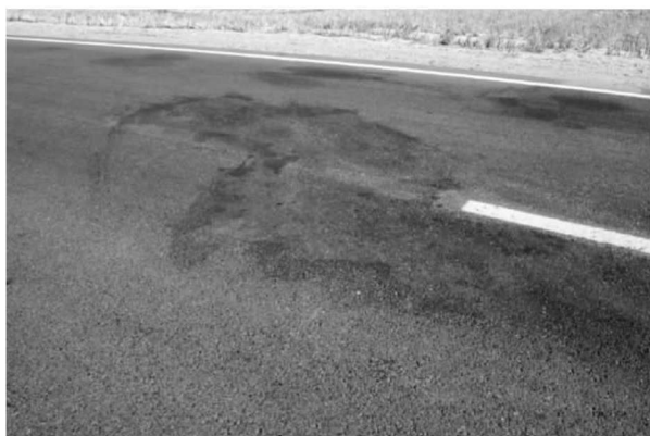
图 1-4 阿和沙漠公路路面层间结合状况
