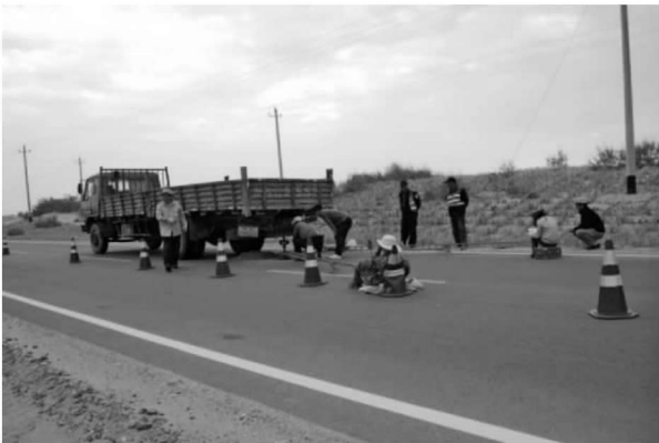
图 1-6 承载板测试
