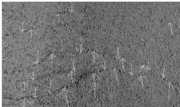
图 1-3 阿和沙漠公路网裂
