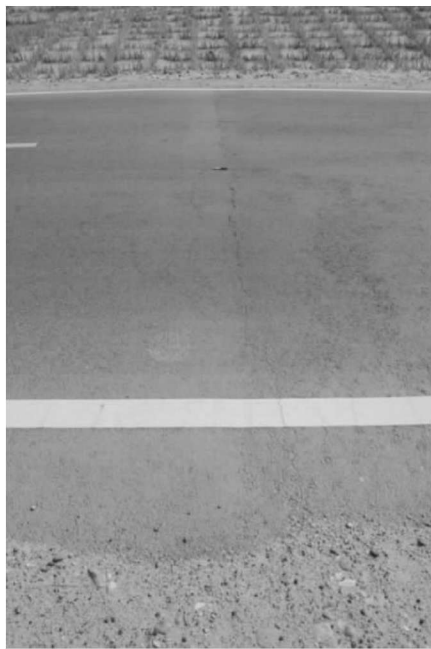
图 1-1 阿和沙漠公路横向裂缝
