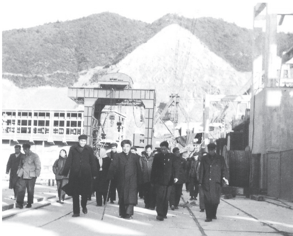
全国人大委员长朱德视察新安江水电站工地
