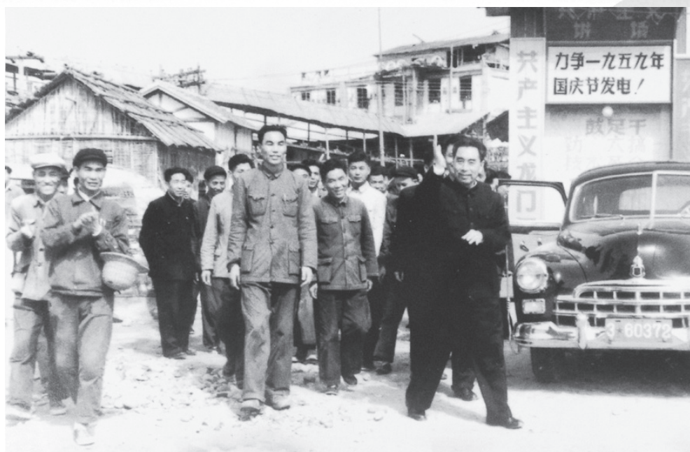
国务院总理周恩来视察新安江水电站工地
