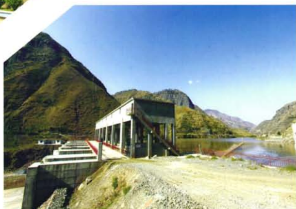
英雄坡二级电站引水大坝
