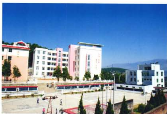
普格中学综合楼
