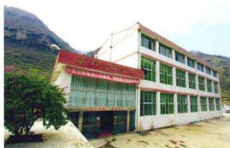
永裕公司英雄坡二级电站
