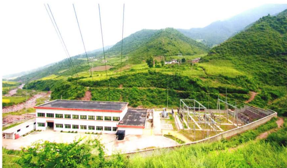
永裕公司小兴场二级电站
