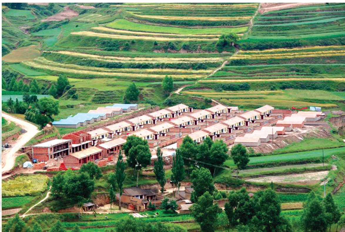
正在建设中的新农村（田原 摄）
