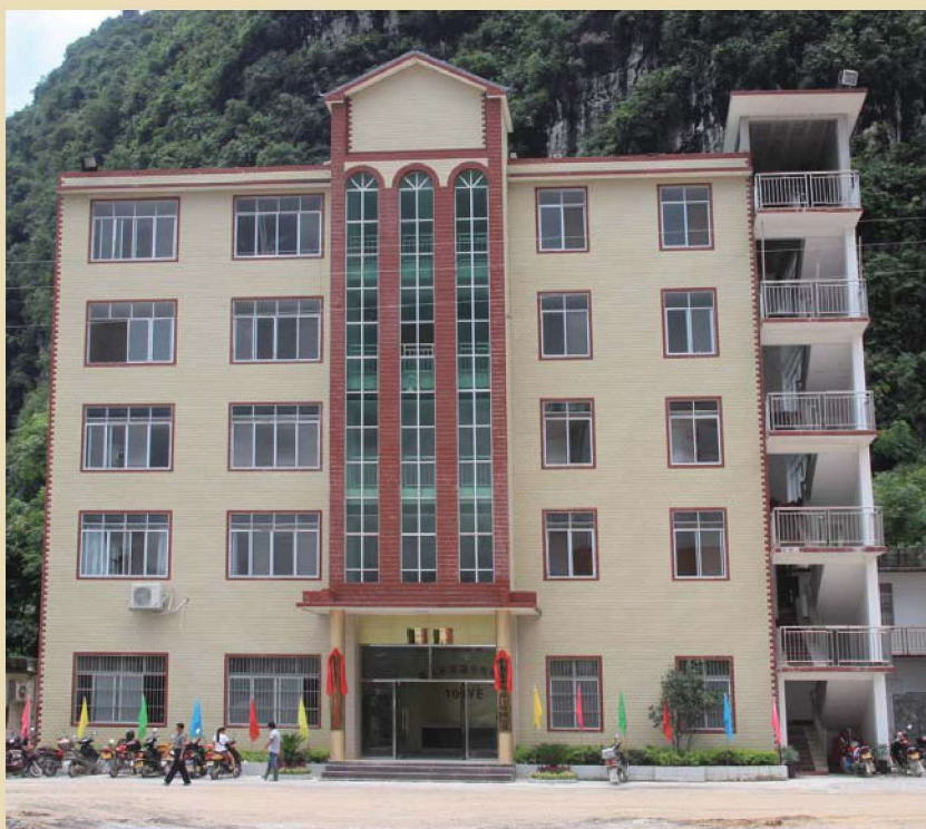
百业公司办公大楼
