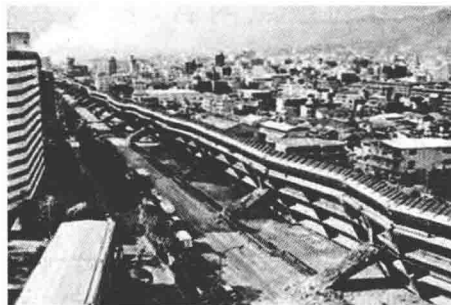
图 0-5 阪神地震建筑物破坏
