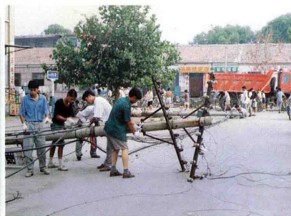
▲机线员们冒着高温抢修被汽车挂倒的市话线路
