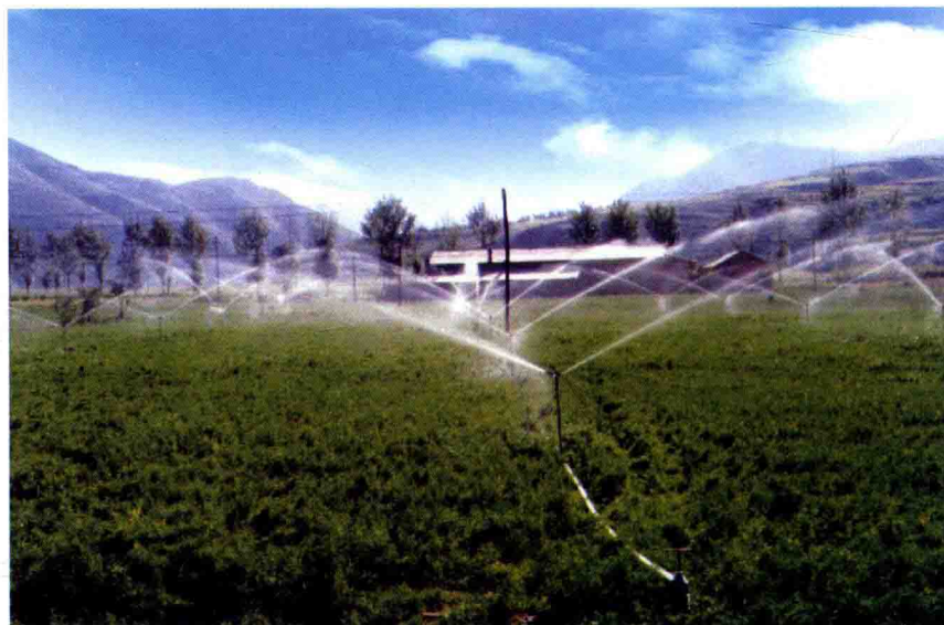
隆化水利喷灌工程
