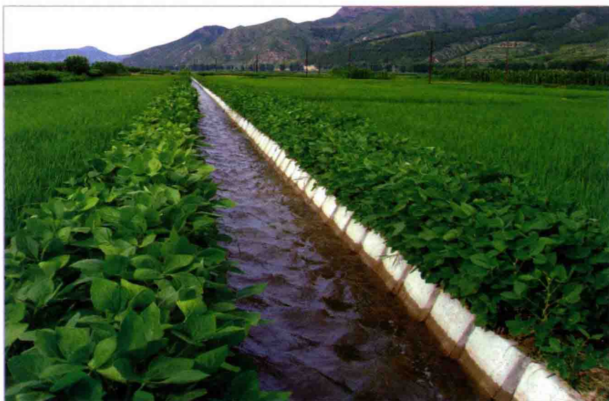
隆化水利防渗渠道工程
