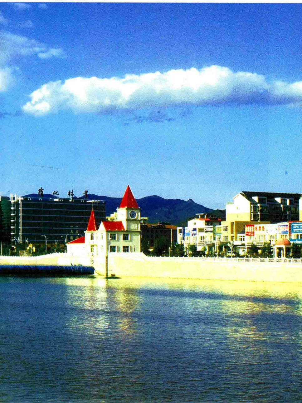
隆化县城橡胶坝
