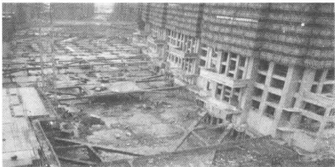
图 1.1.3-9 施工场地越来越紧凑
