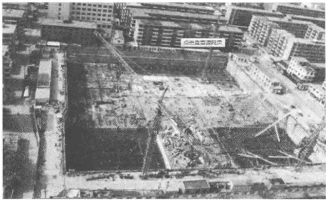
图 1.1.3-10 某大型基坑在紧凑的场地中的现状
