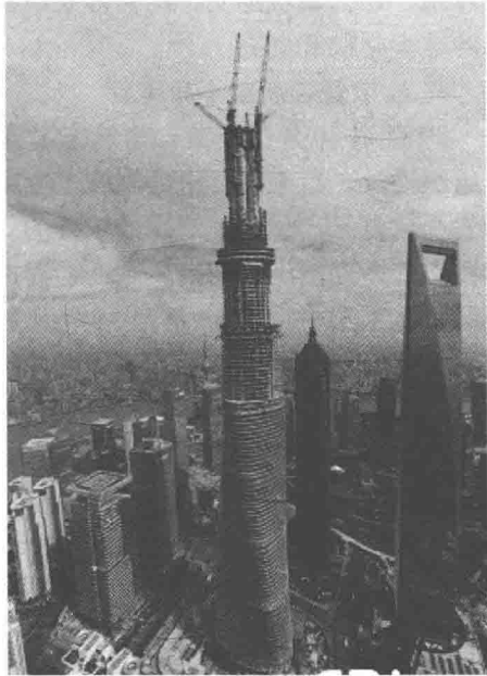
图 1.1.3-2 上海中心大厦施工照片
