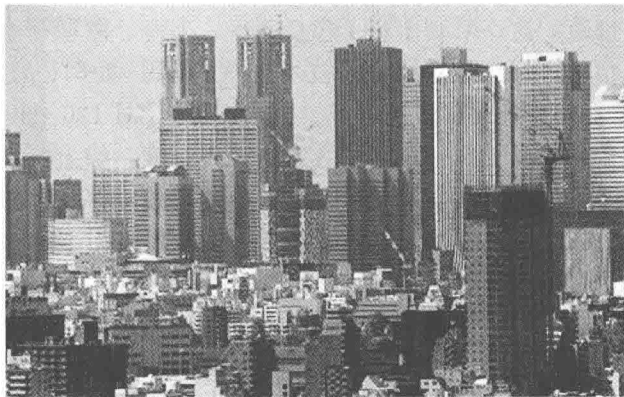
图 1.1.1-1 某市高层建筑林立
