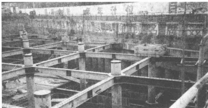
图 1.1.1-5 地下结构的逆作法施工
