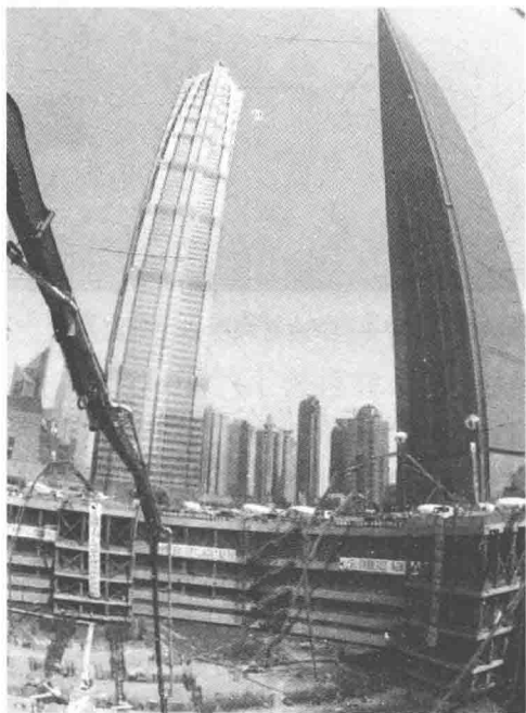
图 1.1.3-6 上海中心大厦主楼基坑施工现场
