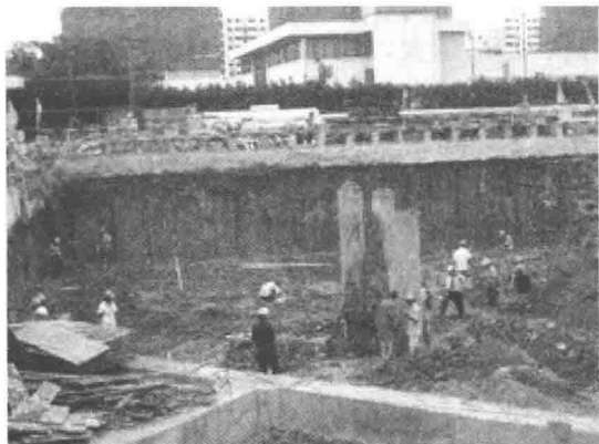
图 1.1.1-4 某 SMW 工法墙的施工现场
