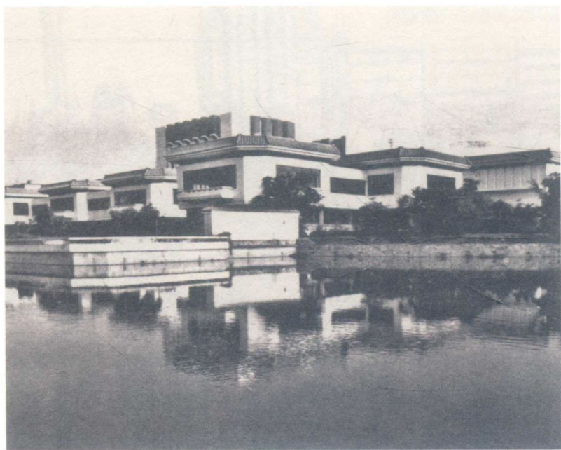
1986年11月25日，作为20世纪80年代深圳八大文化设施之一——深圳图书馆馆舍全面竣工。
