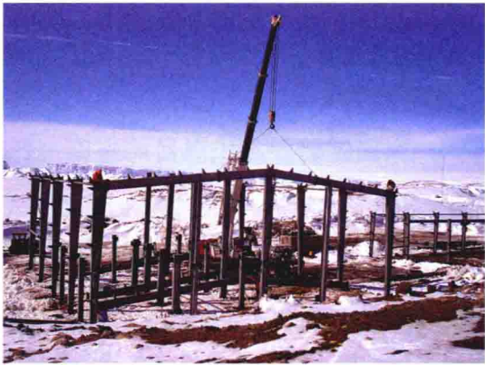
图 7 钢结构吊装
