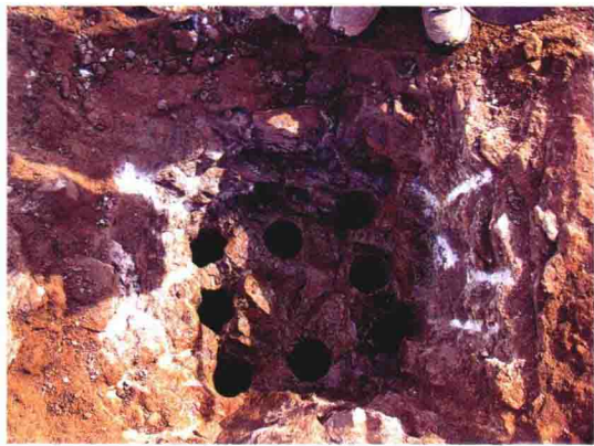
图 5 基岩钻孔成孔
