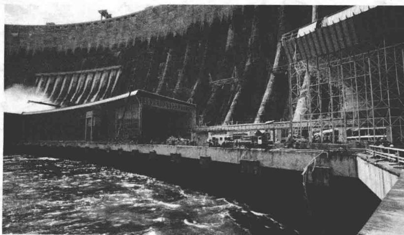
图 1.7 摧毁的电厂厂房
