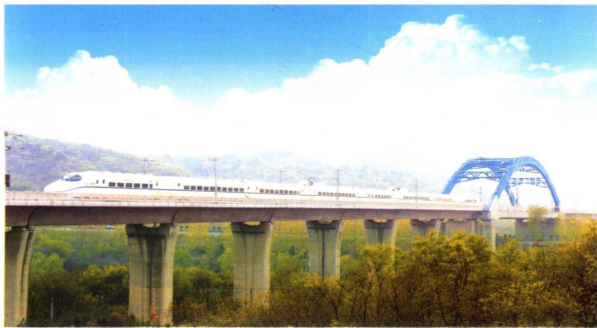
图 1-3 高速铁路桥梁
