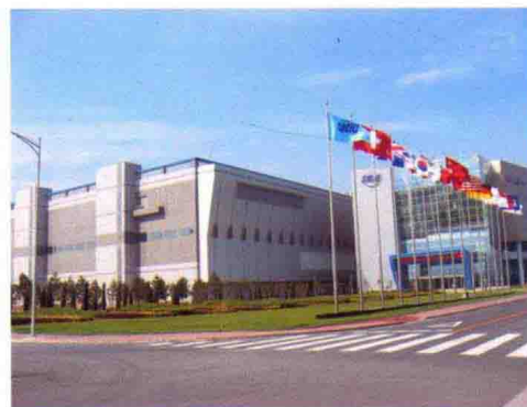
图12 北京中芯国际公司厂房
