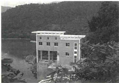
(a) 罗岙水库取水口
