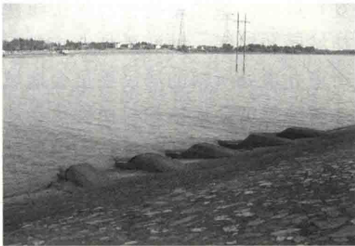
(b) 扬州万福源水厂取水口
