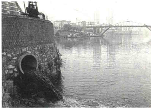
图 1-2-7 暗管排污口（敷设深度较小）
