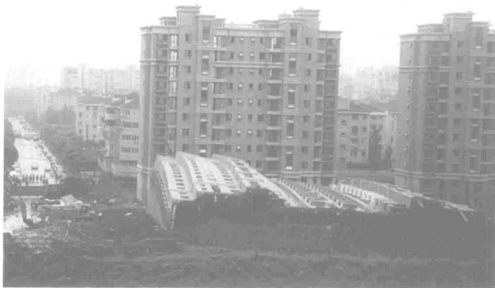
图 1-2 上海市闵行区“莲花河畔景苑”小区倒塌事故
