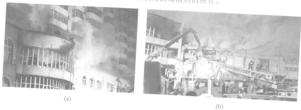
图 1-5 火灾引起的房屋损伤
