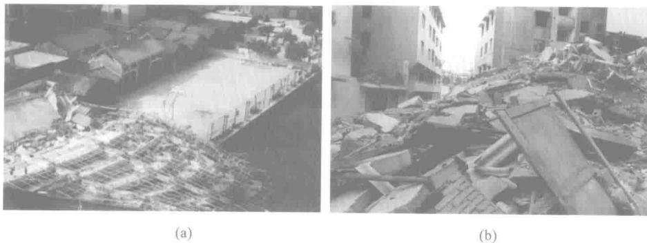
图 1-3 房屋维护和使用不当引起的倒塌
