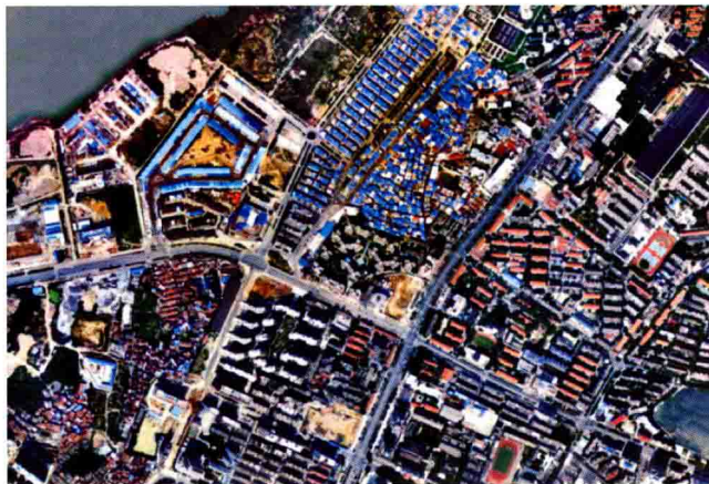
2009年10月东沙湖连通工程建设前区域航拍
