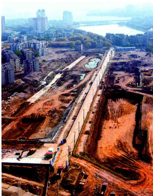
建设中的东沙湖连通工程
