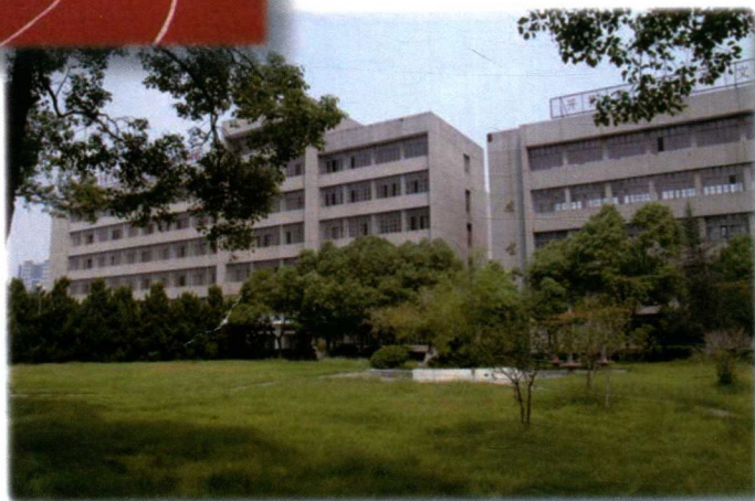
南昌工程学院彭家桥校区教学楼和图书馆
