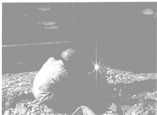
图8 接桩焊接现场图
