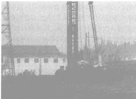
图6 走管式打桩机
