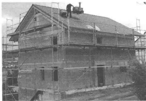
图 1.10 砖混结构示意图
