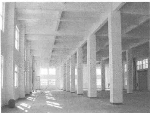
图 1.9 框架结构示意图
