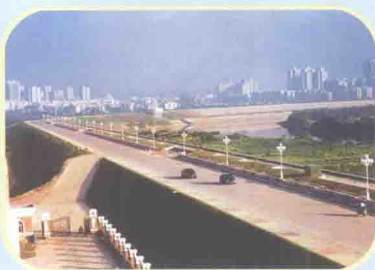
按百年一遇防洪标准，采用“堤路结合”方式完成加固的惠州大堤二期工程
