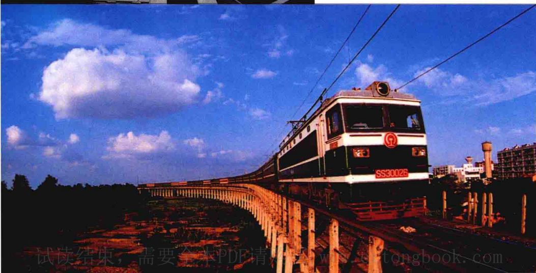
◀ 全国铁路最长旱桥襄樊铁路枢纽金华寺大桥
