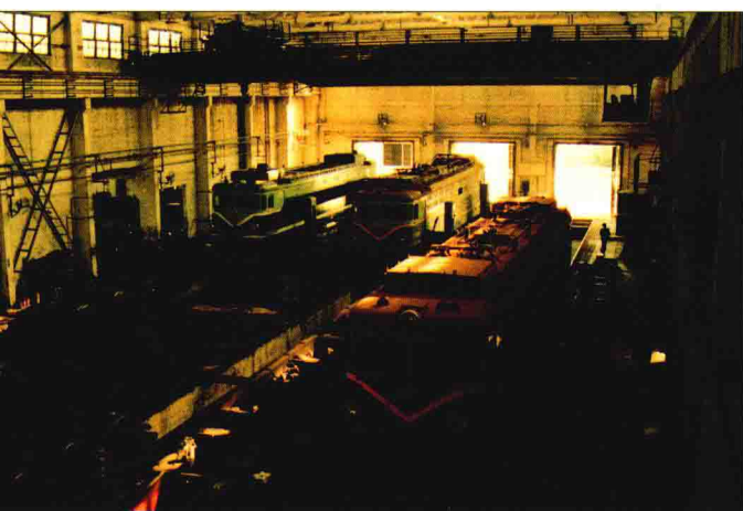
▲ 六里坪机务段电力机车架修库
