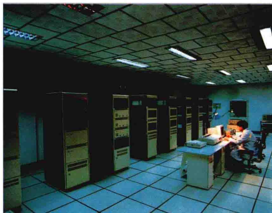
▲ 襄樊北车站驼峰雷达测车速装置
