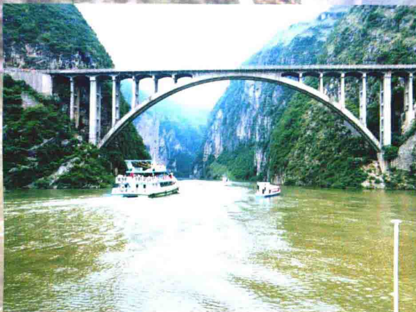
二期水位龙门桥
