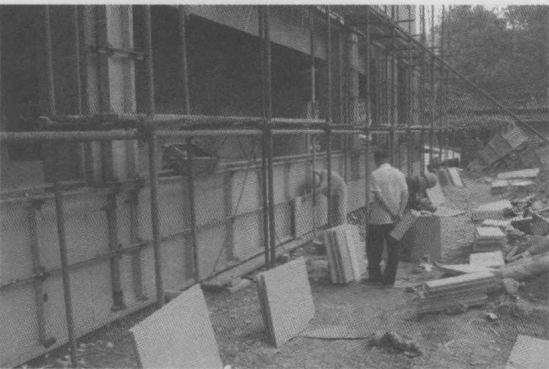
图 1-9 钉挂施工
