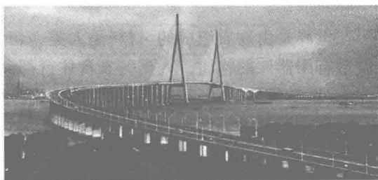
图 0-1 苏通长江公路大桥
