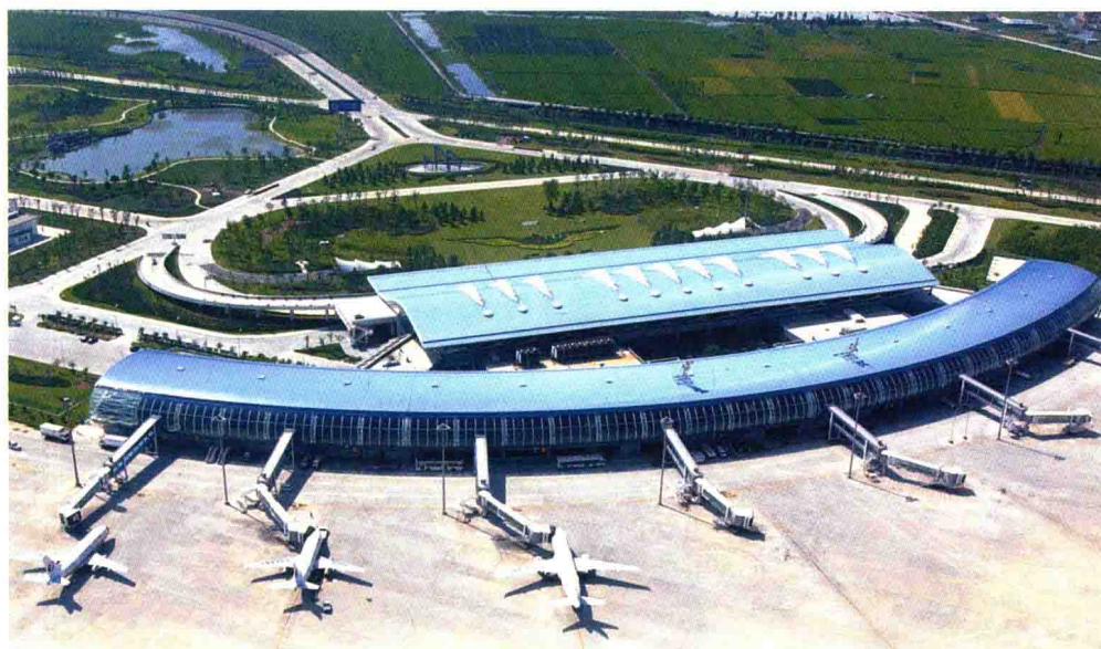
栎社机场全景
