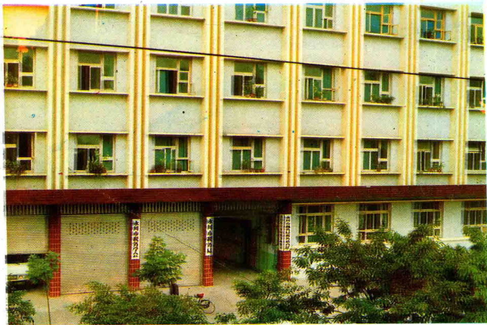
永川县税务局办公楼
