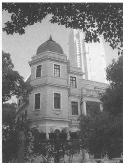
荣家老宅角楼
