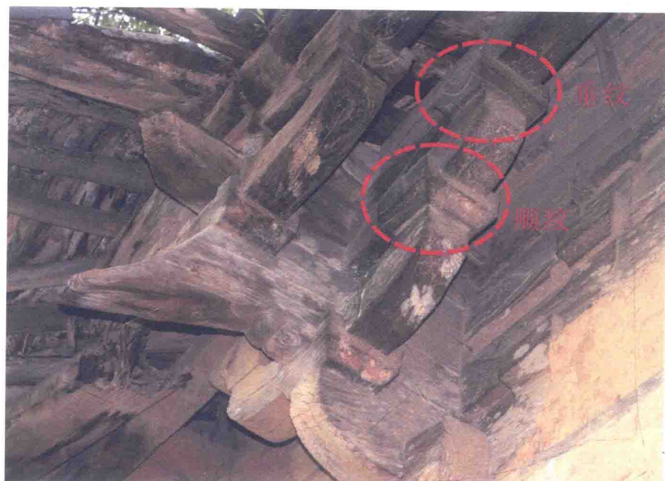
彩图 31 西山南平柱头铺作斗的加工方式
