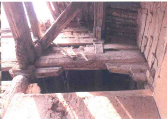
彩图 17 山面柱头铺作
