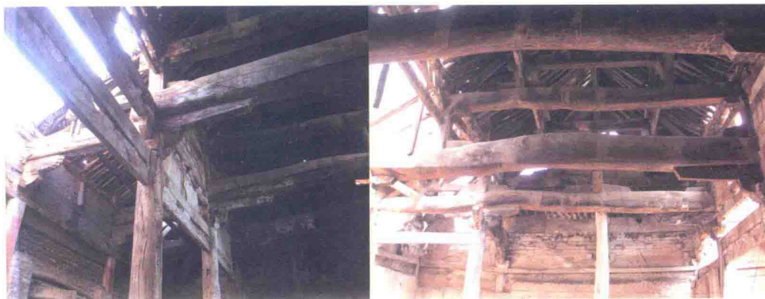
彩图 12 八架椽屋乳栿衬六椽栿用三柱
