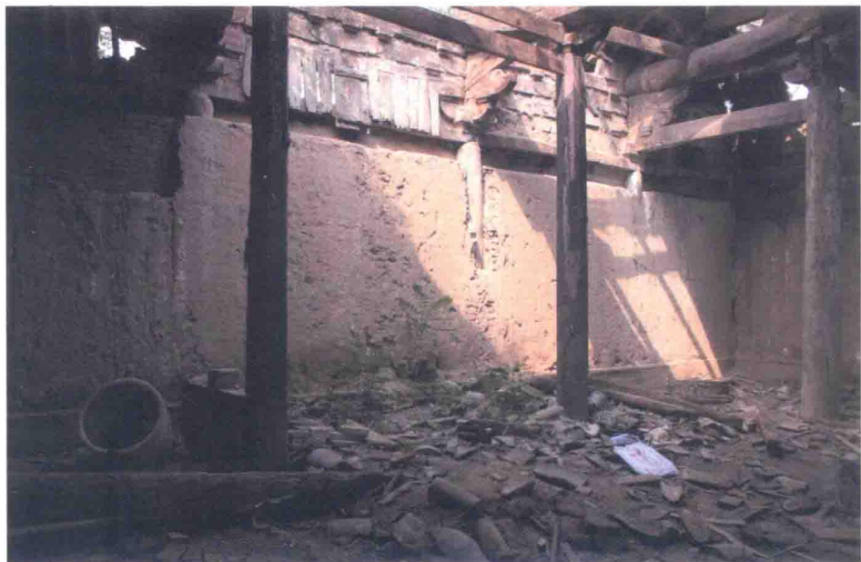
彩图 19 平面移柱造
