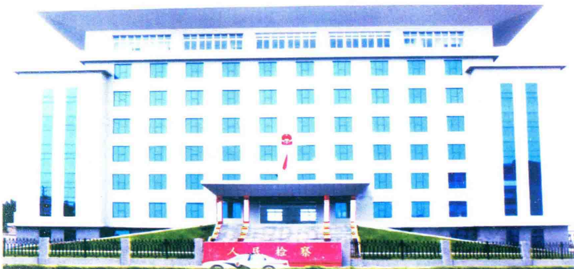
▲ 图为2007年底，华容区人民检察院新建办公、侦查、技术综合大楼。该楼建筑面积3800平方米，座落于区政府附近。
