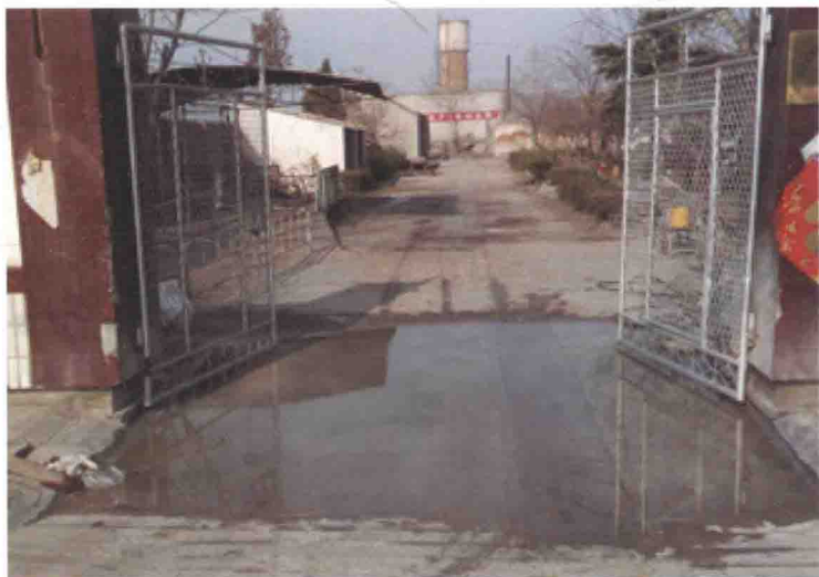
图 1-12 生产区消毒池
