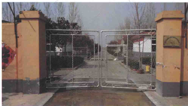
图 1-1 未建顶棚的猪场消毒池（王辉摄）
