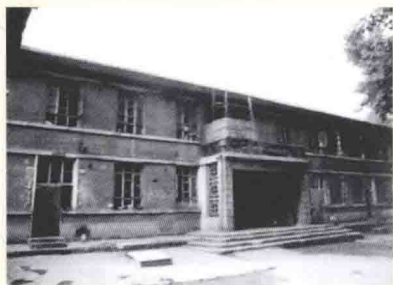
建矿初期的办公楼
