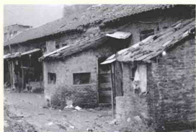
沁新煤矿员工旧宅
