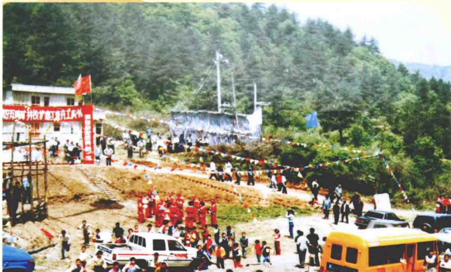
1997年5月14日，45万吨矿井改扩建工程开工典礼在贾家沟工地隆重举行
