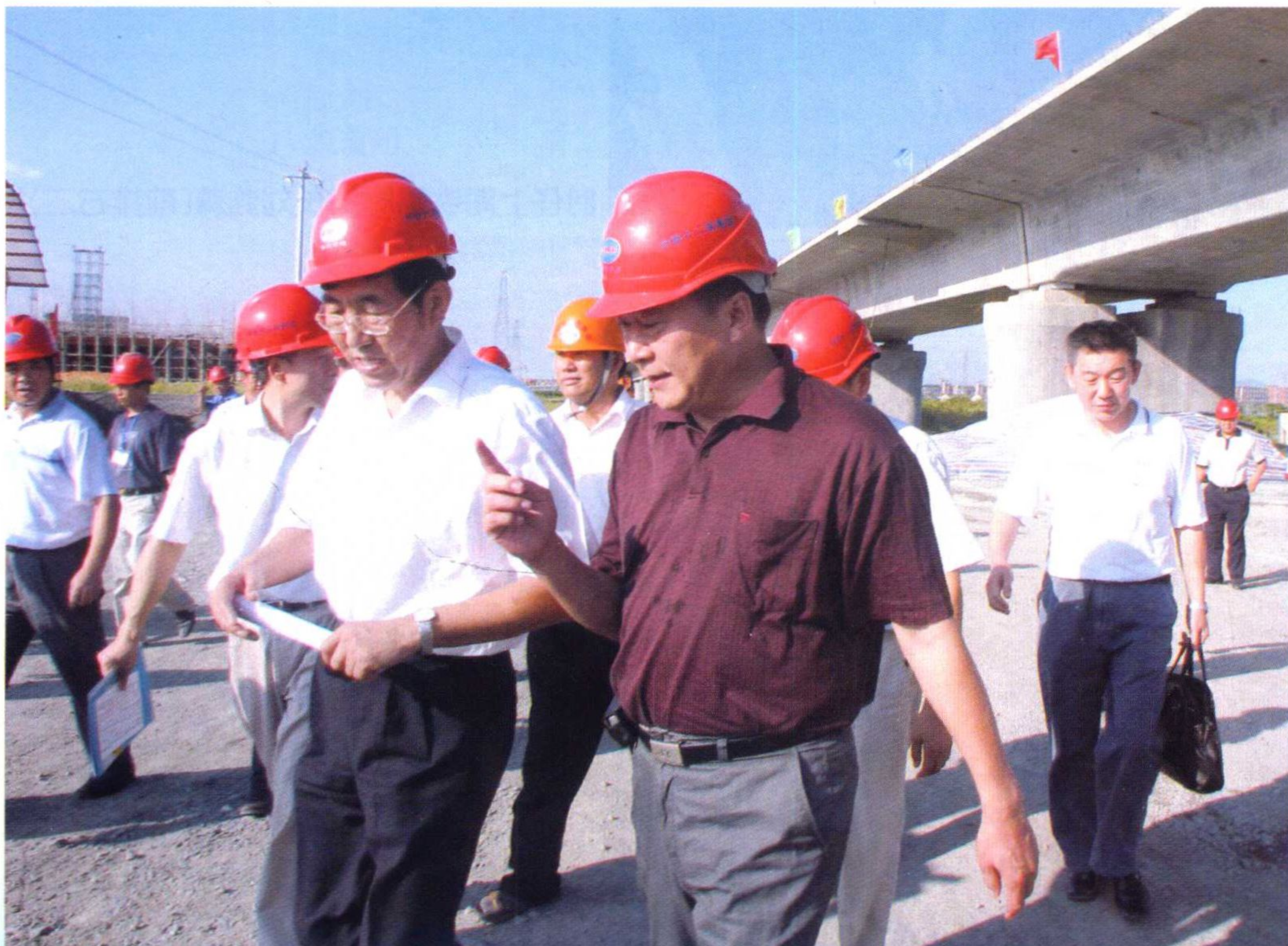
时任宁波市委书记巴音朝鲁(前排左一)视察鄞县大道特大桥工地
