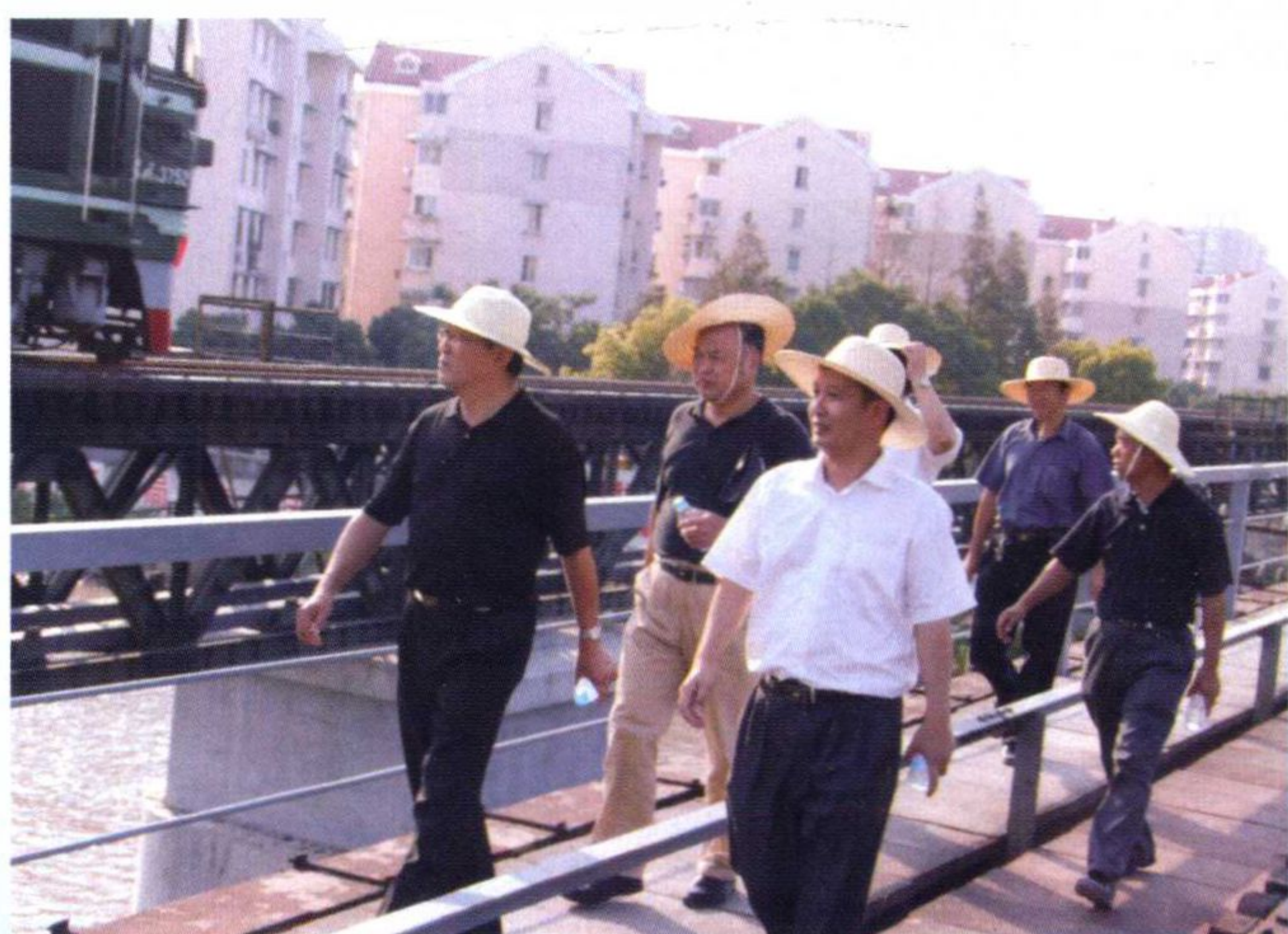
沿海公司副总经理吴炯(前排左二)在工地检查
