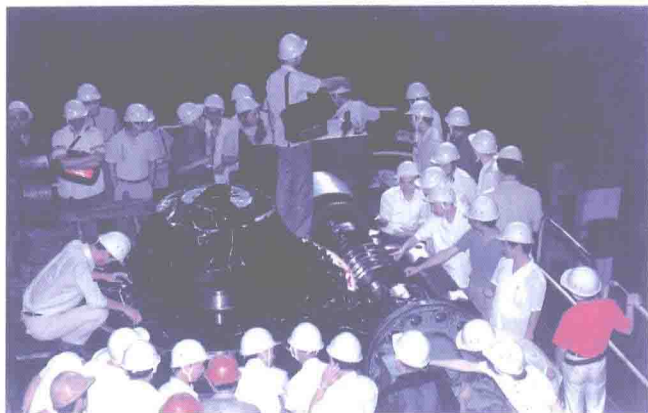
现场指导安装太钢 1200 轧钢机传动副(2)
