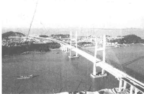
图 1-14 厦漳跨海大桥防撞钢套箱
