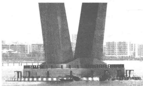
图 1-16 湛江海湾大桥防撞橡胶钢丝圈
