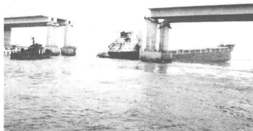
图1-8 金塘大桥船撞事故
