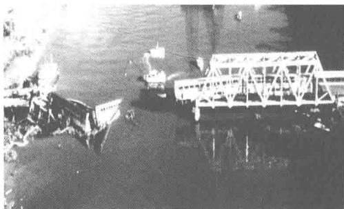
图 1-3 美国 CSX 铁路大桥船撞事故
