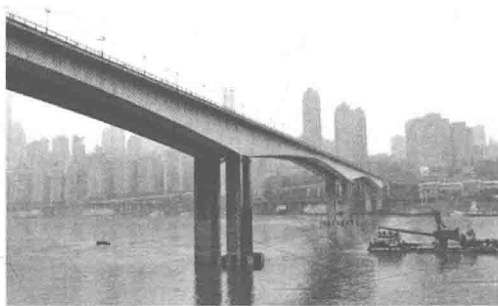
图 1-15 黄花园嘉陵江大桥防撞复合材料套箱
