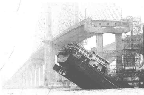
图1-7 九江大桥船撞事故
