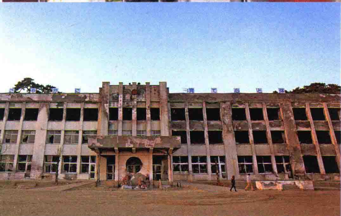
在“3·11”大地震中受到破坏的日本小学
