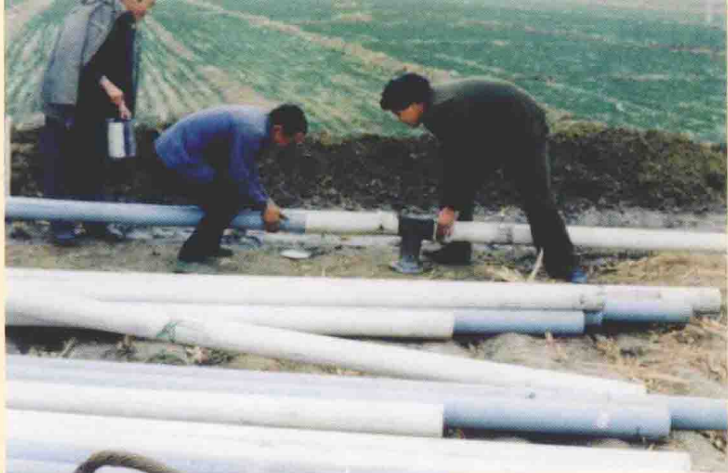
地下输水管道施工
